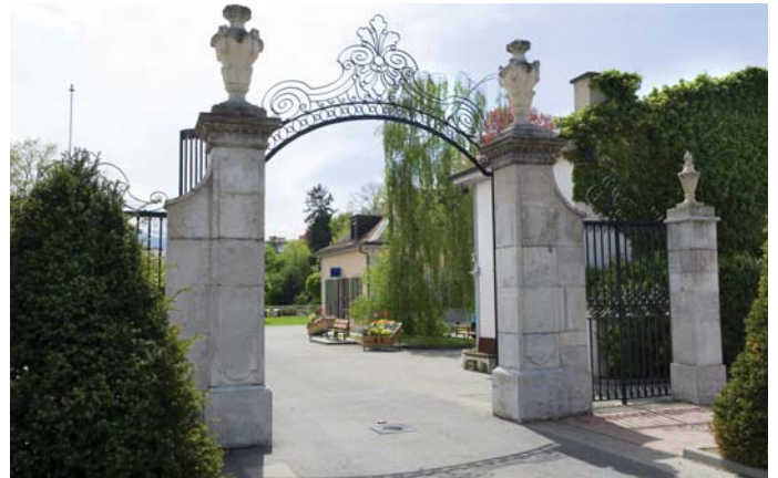
Entrée principale du campus
