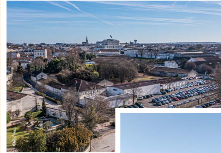
Vue aérienne du futur siège en bord de Charente à proximité du centre historique de Cognac
