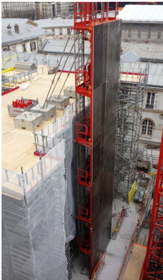
pose du voile ©Cyrille Castel
